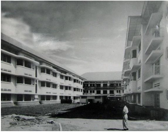
Djakarta, proyek pembangunan perumahan tahun 1952 oleh de Associatie dengan J. Jiskoot . HNI
