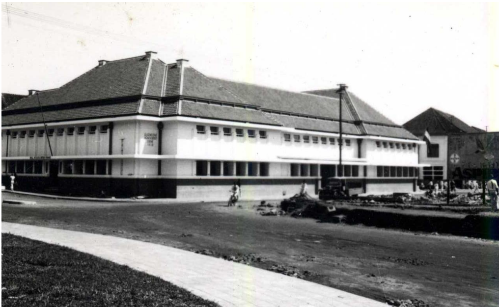
Palembang, Escompto- en Volkscredietbank tahun 1938. A. Fermont bekerja untuk Fermont-Cuypers. CFC
