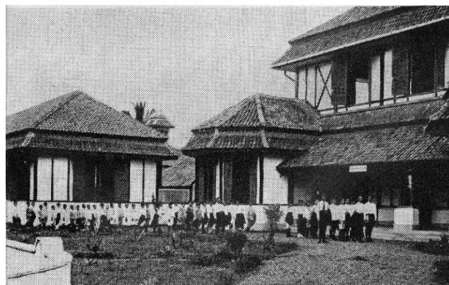
Soekaboemi, Opvoedingsgesticht tahun 1926. Architect H. hes. Coolhaas (1946) hal. 148
