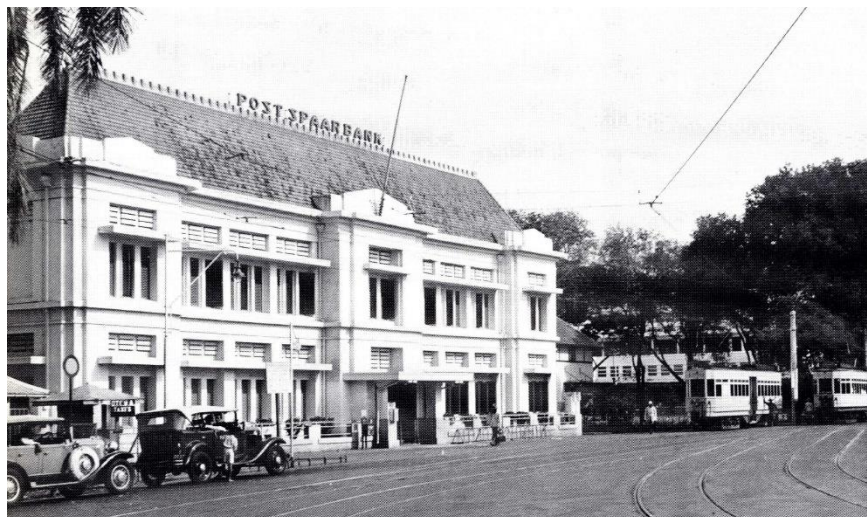
Batavia, de Postspaarbank setelah pembangunan tahun 1934. Arsitek J. van Gendt dari BOW. COF
