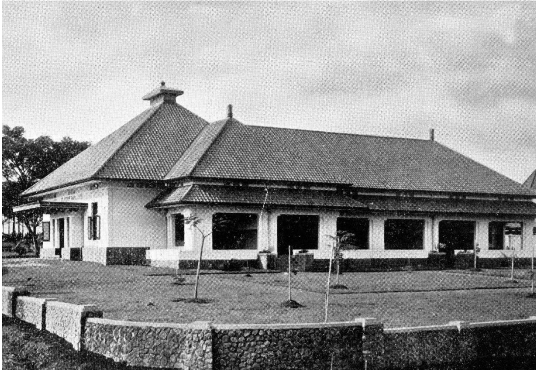
Bandoeng, paviliun rumah sakit St. Borromeus tahun 1927. Th. Taen dan A. Fermont bekerja untuk Fermont-Cuypers. CFC
