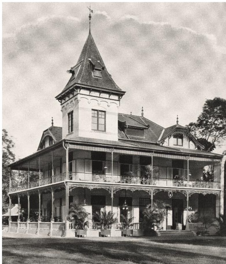
Batavia, rumah direksi Electriciteitsbedrijf tahun 1907, A. van Driesum. sumber 'gedenkboek' (buku peringatan)
