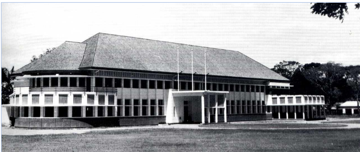
Medan: kantor Bataafsche Petroleum Mij, Jl. Sultan Maamum Alrasjid tahun 1952. Arsitek J.F.L. Blankenberg. Loderichs (1997) hal. 145
