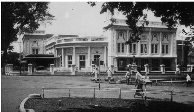
Malang, Societeit Concordia (pembangunan) tahun 1895, Arsitek A du Bois/- KITLV
