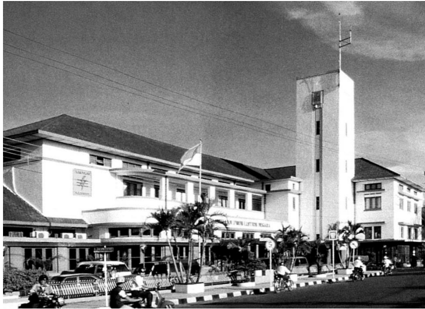
Malang, bekas gedung ANIEM tahun 1941. Arsitek R. Rijkzen. Schaik 1996 hal. 132
